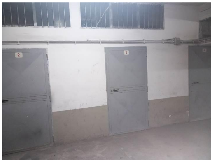
Viste del locale di deposito
