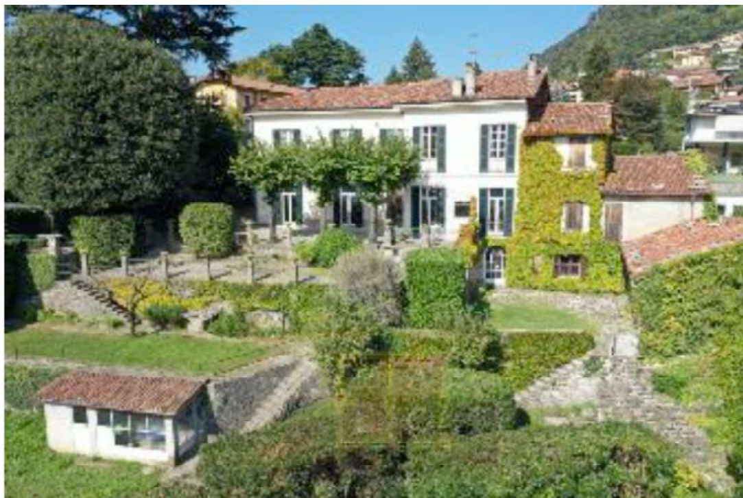
Vista esterna (lato Sud-Est)
