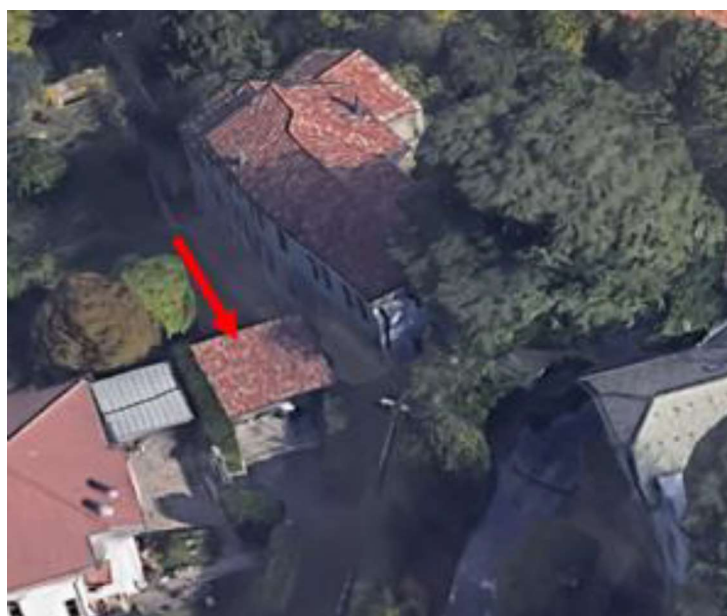
Fotografia 3D della tettoia (mapp. 2413 sub. 4 insistente sulla particella 3533)
