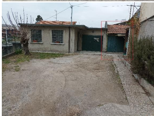
Vista da cortile
